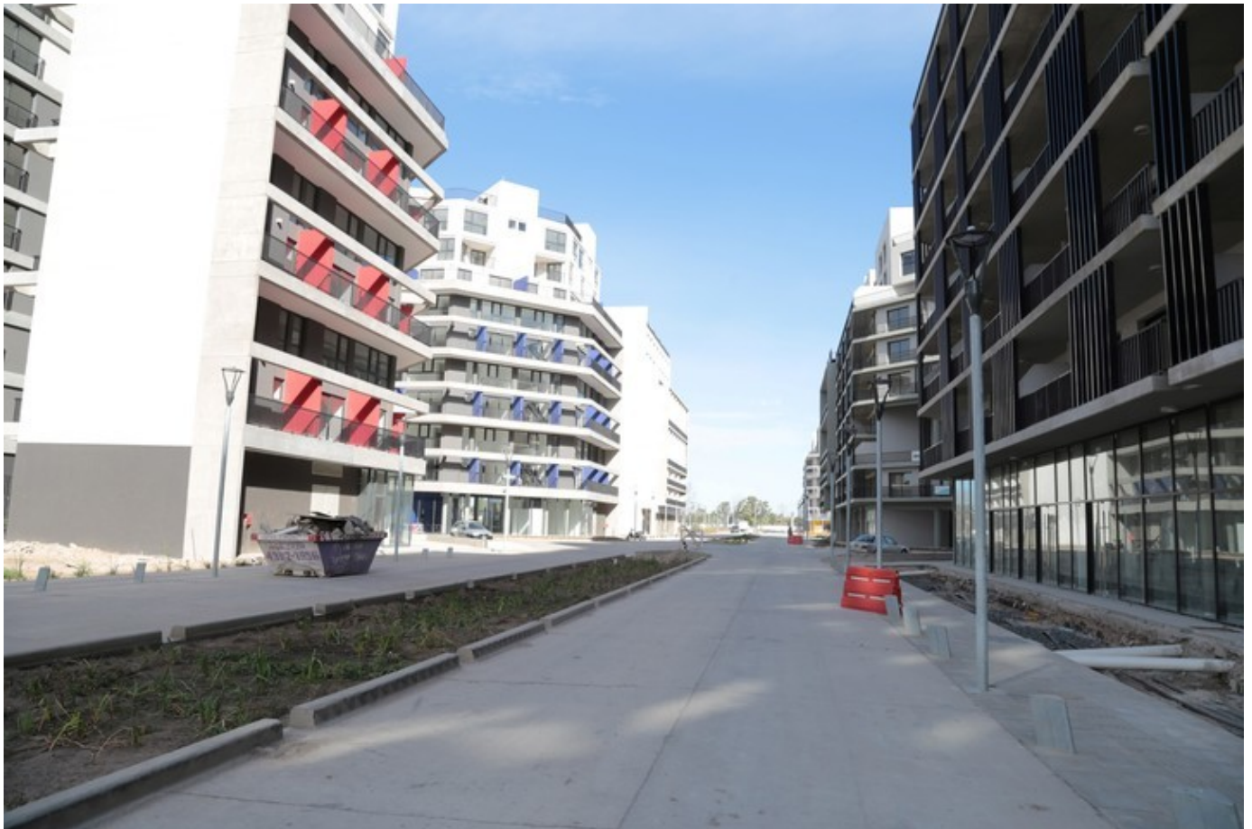
El complejo cuenta con 31 edificios.
