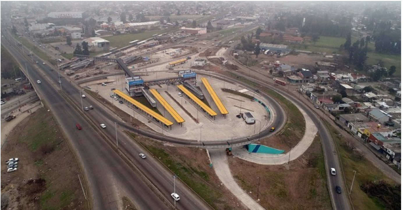
Después. El predio del Centro de Tránsito del Metrobus La Matanza.
