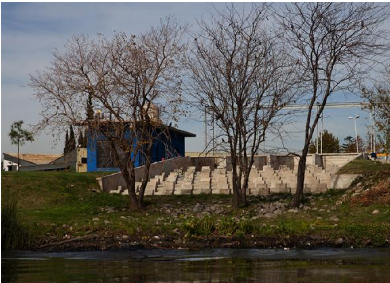
Cascadas en el riachuelo para oxigenar el agua. Foto: LA NACION / Matías Aimar
